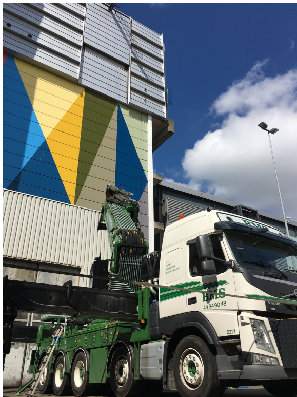
BMS kranen klar til løft under lugen ind til affaldssiloen.
