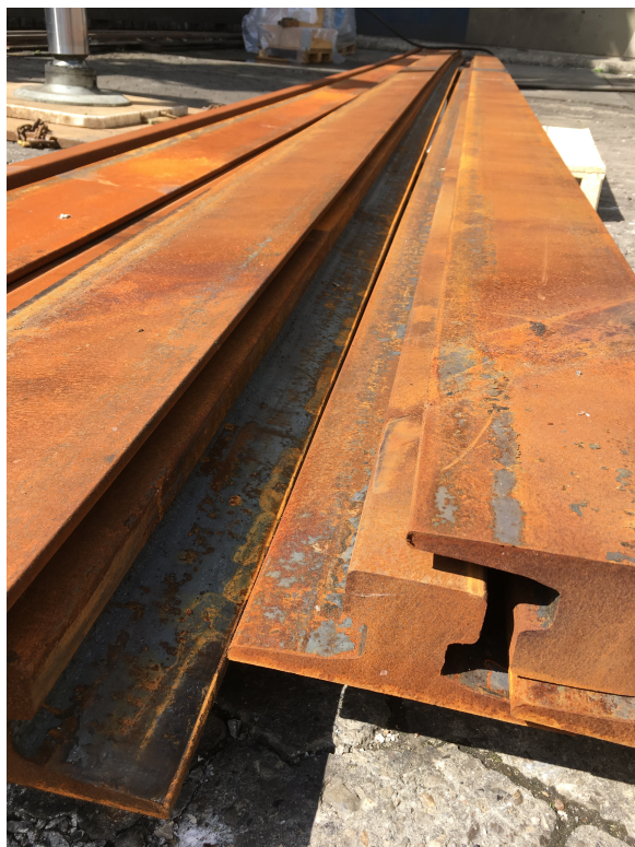
Nye kransinner til montering inde under affaldsiloens loft.
