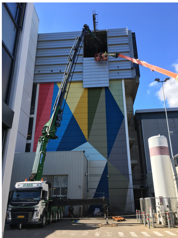
En kransinne løftes ind i affaldsiloen..
