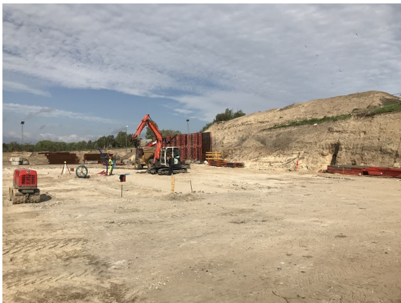
Der bliver gjort klar til den nye belægning
