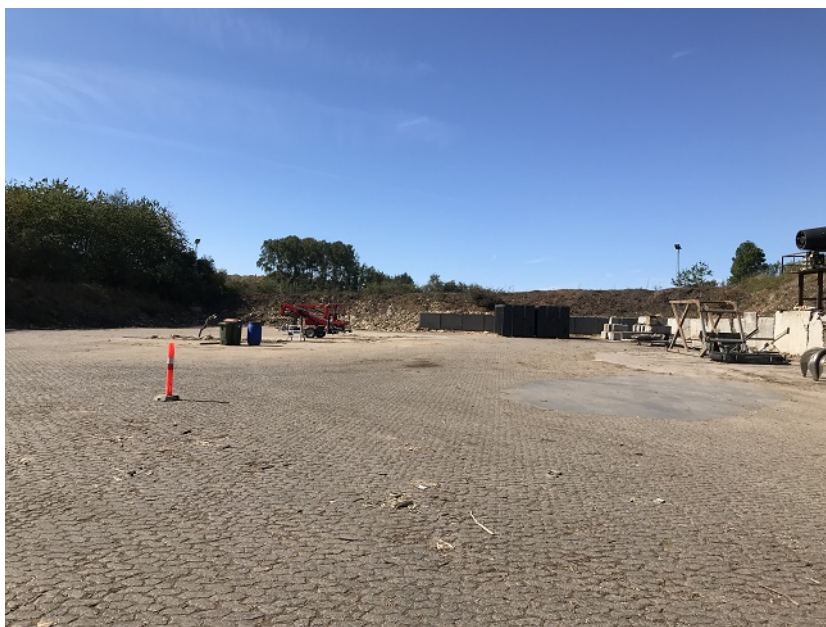
Den gamle belægning, før den blev fjernet
