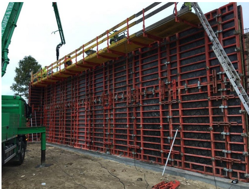
Støbning af 5,5 meter betonvæg
