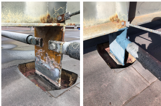
Nedstik før afrensning og efter primning.
