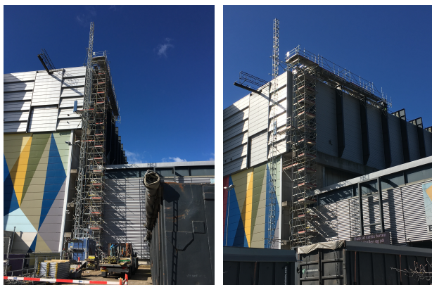
Stillads under udførelse.
