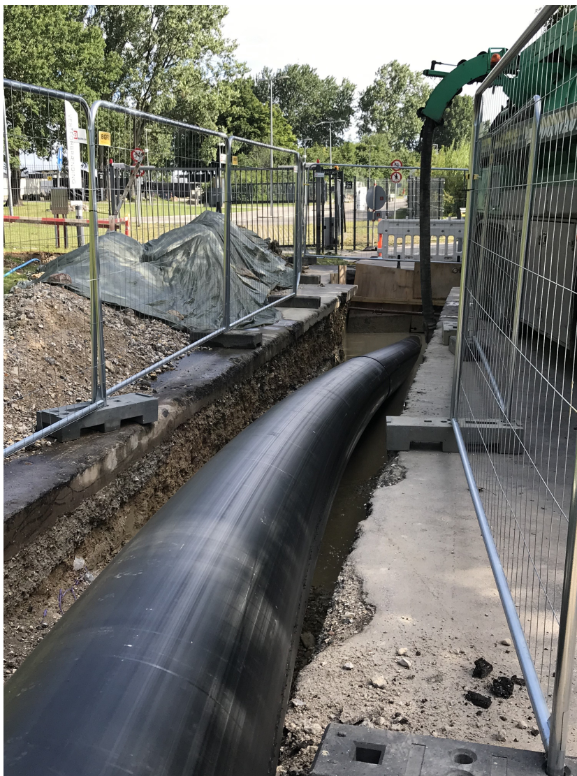
Ø630 regnvandsledningen trækkes igennem, her ses indgangshullet.
