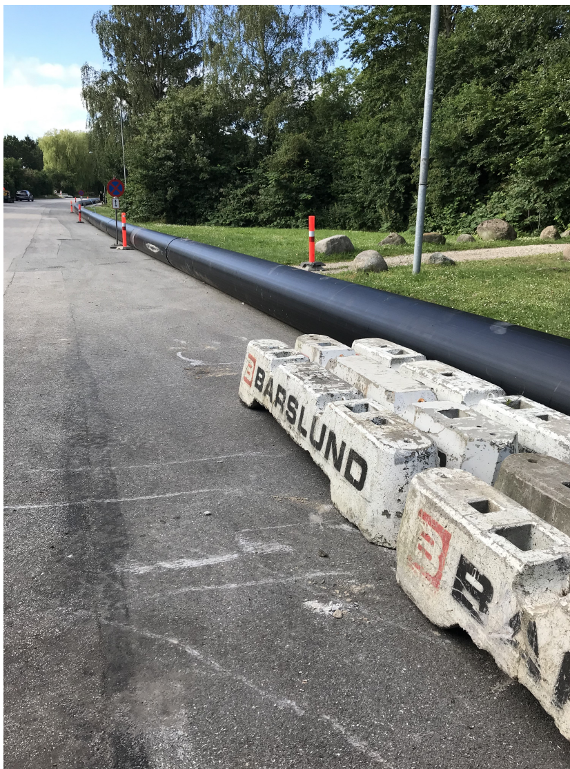
Ø630 regnvandsledningen "slanger sig" ned ad Ejby Mosevej, og bliver stykke for stykke trukket over til CMC-grunden.
