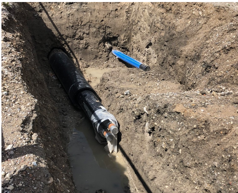
De to allerede gennemførte styrede underboringer.
