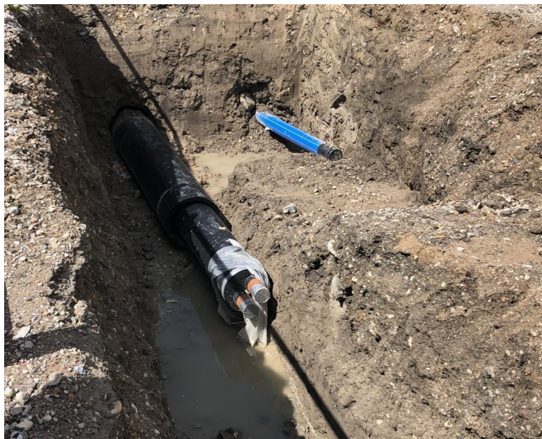
De to allerede gennemførte styrede underboringer.
