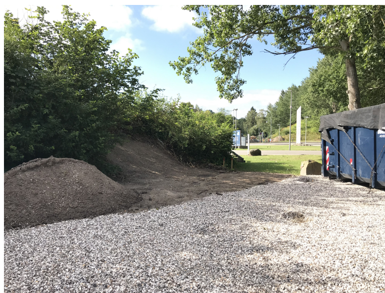
Reetableret terræn på Gruspladsen hvor beplantning af volden udestår.
