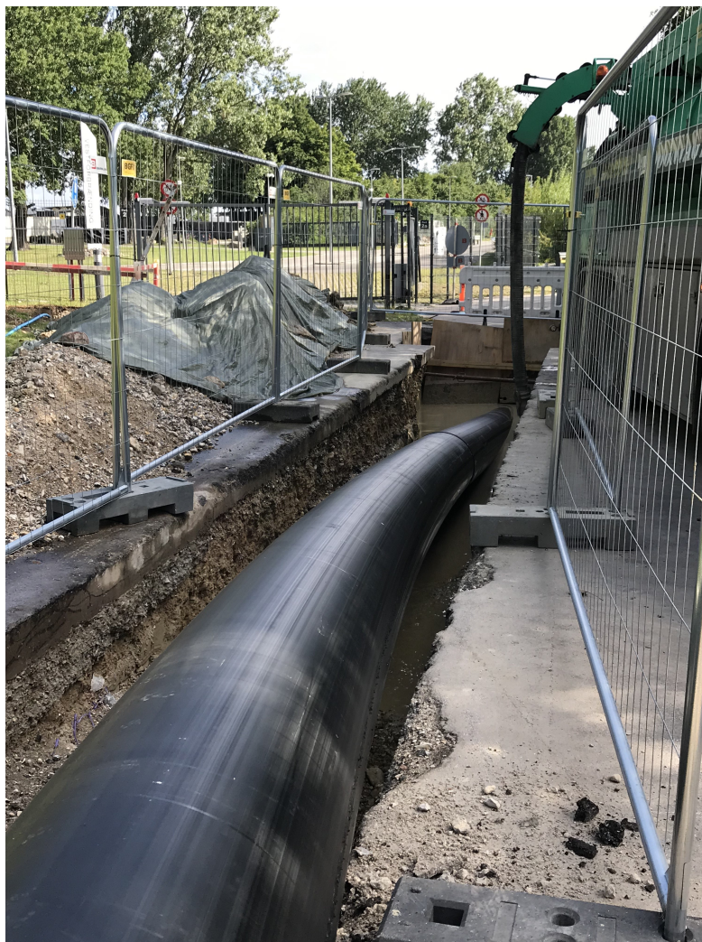
Ø630 regnvandsledningen trækkes igennem, her ses indgangshullet.
